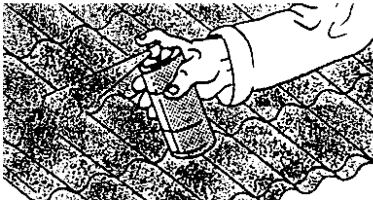
Рис.17. Окраска срезов, сколов и повреждений защитного слоя
